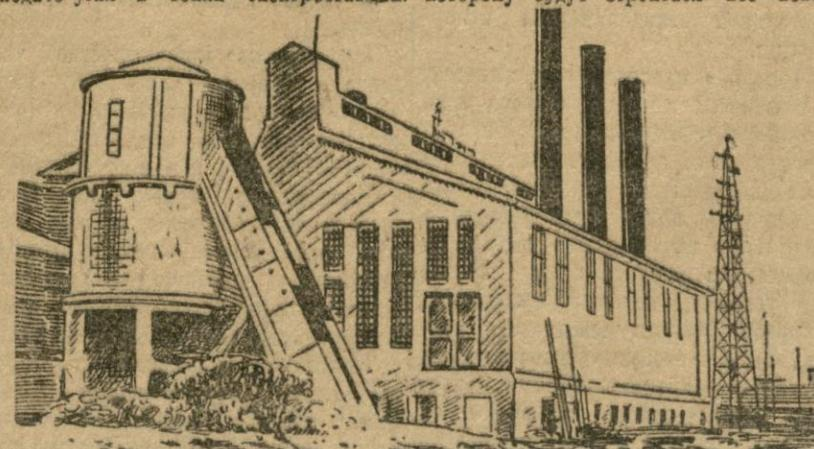
Уголь из вагонов сыпется в бетонный бункер, откуда по элеватору он идет на крышу котельной на доворный горючий
