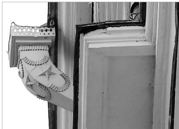
Вадасцёк. Жылы дом па вул. К. Маркса, 45 у Мінску, архітэктар М. Баршч. 1953 г.
