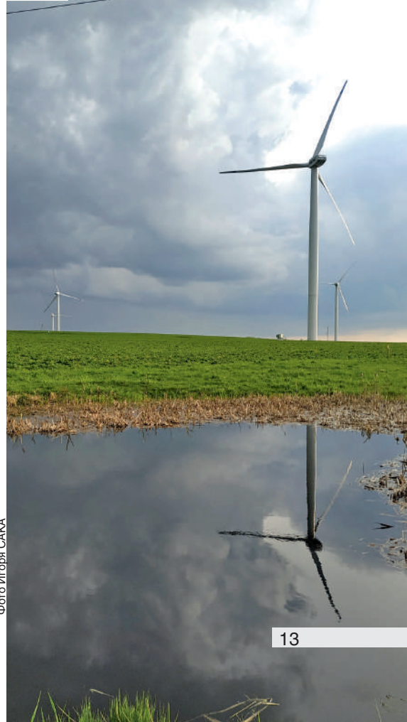
Ветроэнергетические установки в Новогрудке.
