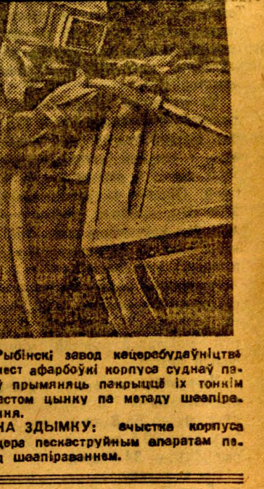
Рыбінскі завод кэшэробудавніцтва замест афарбоўкі корпусу суднаў пачаў прымяняць пакрыццё іх тонкім пластом цынку па метад шэапіравання.
