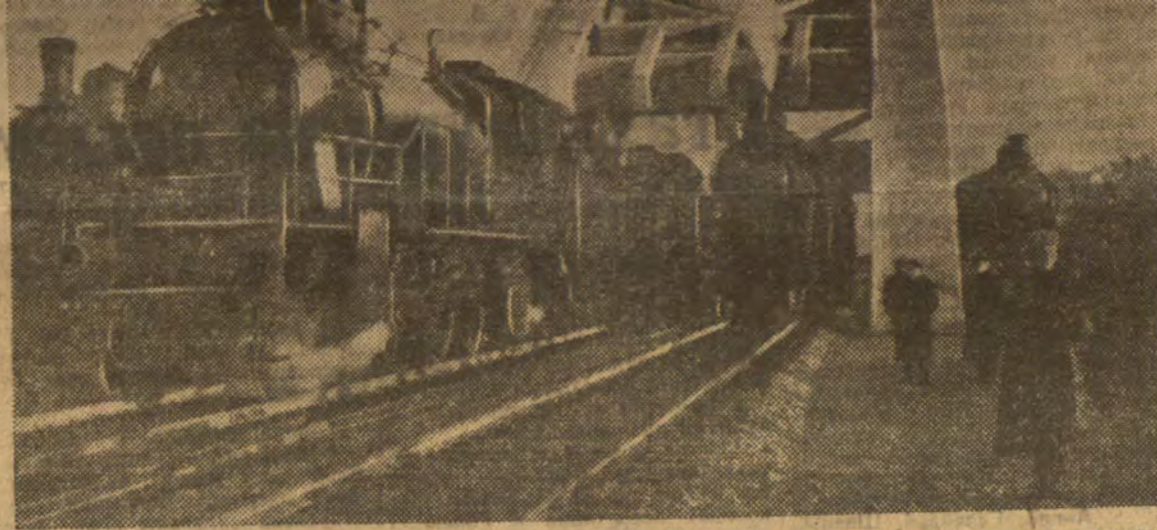
Выпрабаванні Хімінскага маста праз канал Масква—Волга. 1 і 2 лістапада камісія НКШЗ, якую ўзначальваў т. Пашкоўскі, праводзіла выпрабаванні новага 4-путнага жалеза-бетоннага моцнага маста праз канал Масква—Волга ля ст. Хімікі, Окцябрскай чыгункі. На масту адначасова праходзілі 4 паравозы з хуткасцю 60 кіламетраў у гадзіну. Выпрабаванні далі выдатныя вынікі. На здымку: момант праходжання паравозаў.
