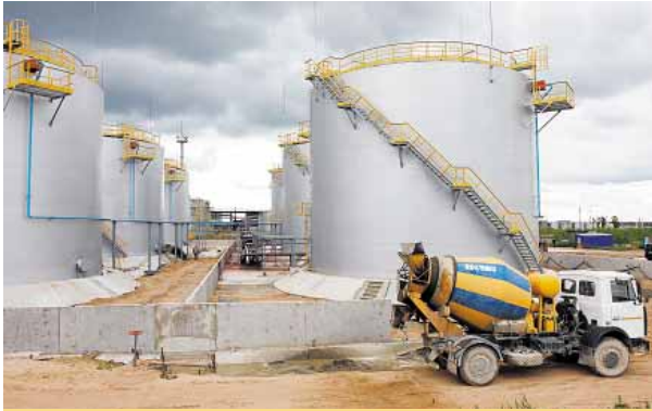
Идет реконструкция резервуарного парка с заменой резервуаров ОАО «Нафтан».
