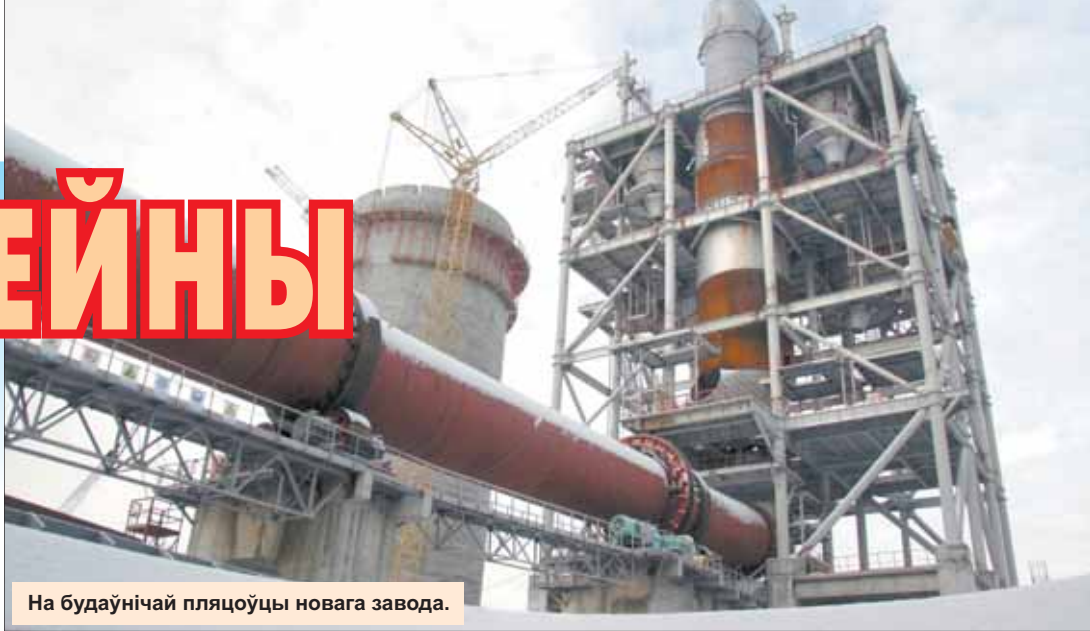
На будаўнічай пляцоўцы новага завода.
