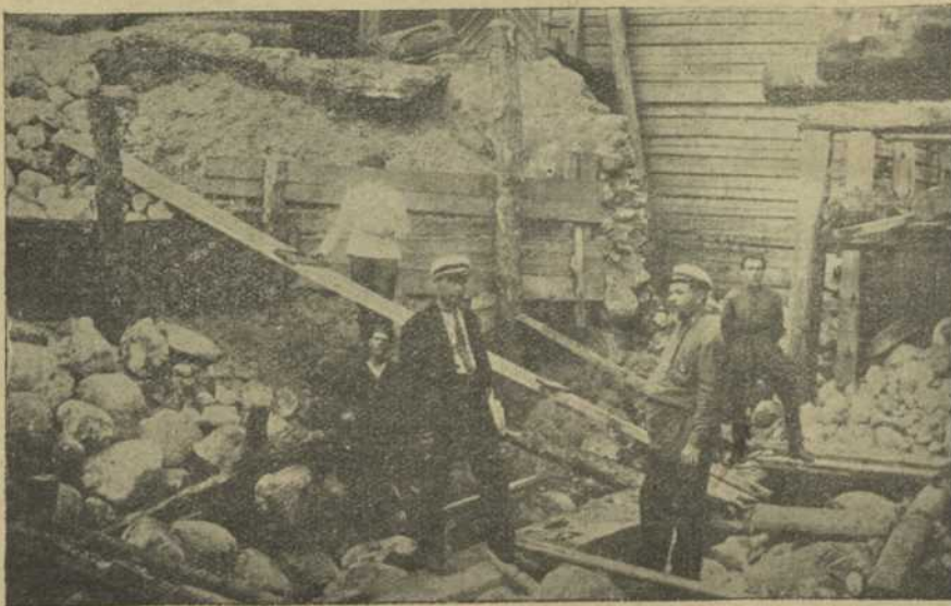
На постройке электро-станции в Острошицко-городицком р. Минокруга.
