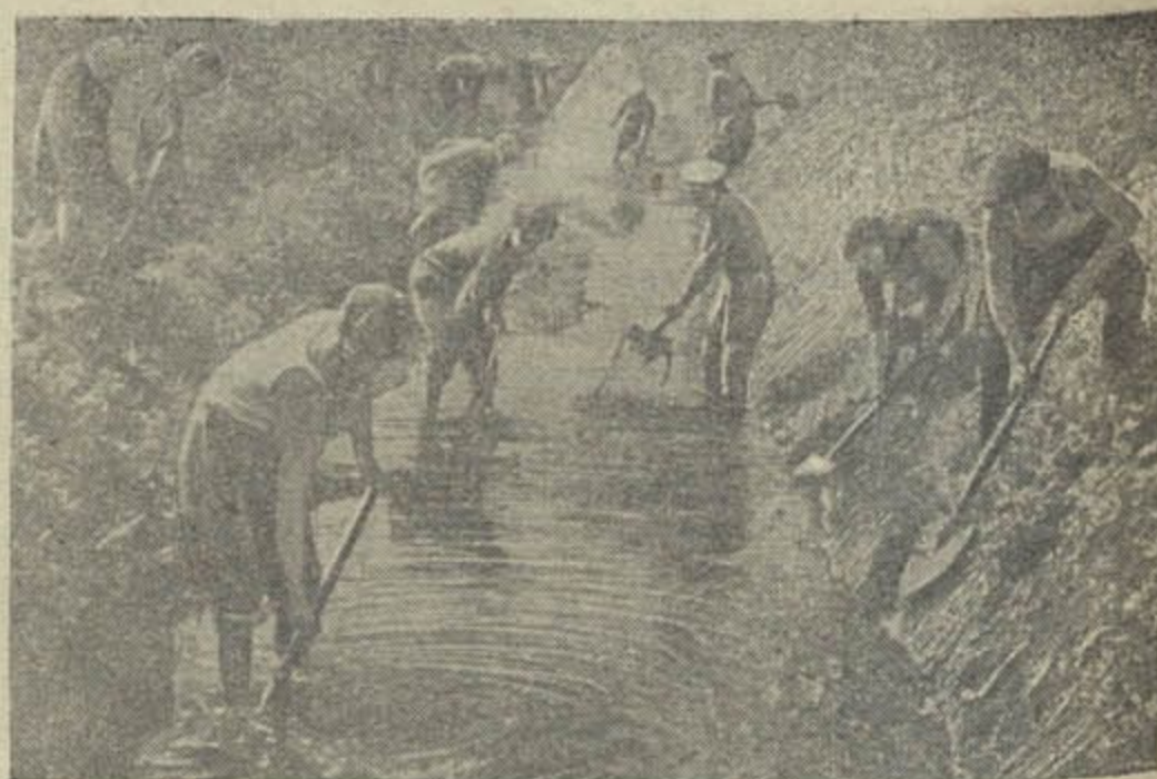
Меліярацыйныя работы на Палессі. Рамонт асушальнага канала ў саўгасе «Ведрыч».
