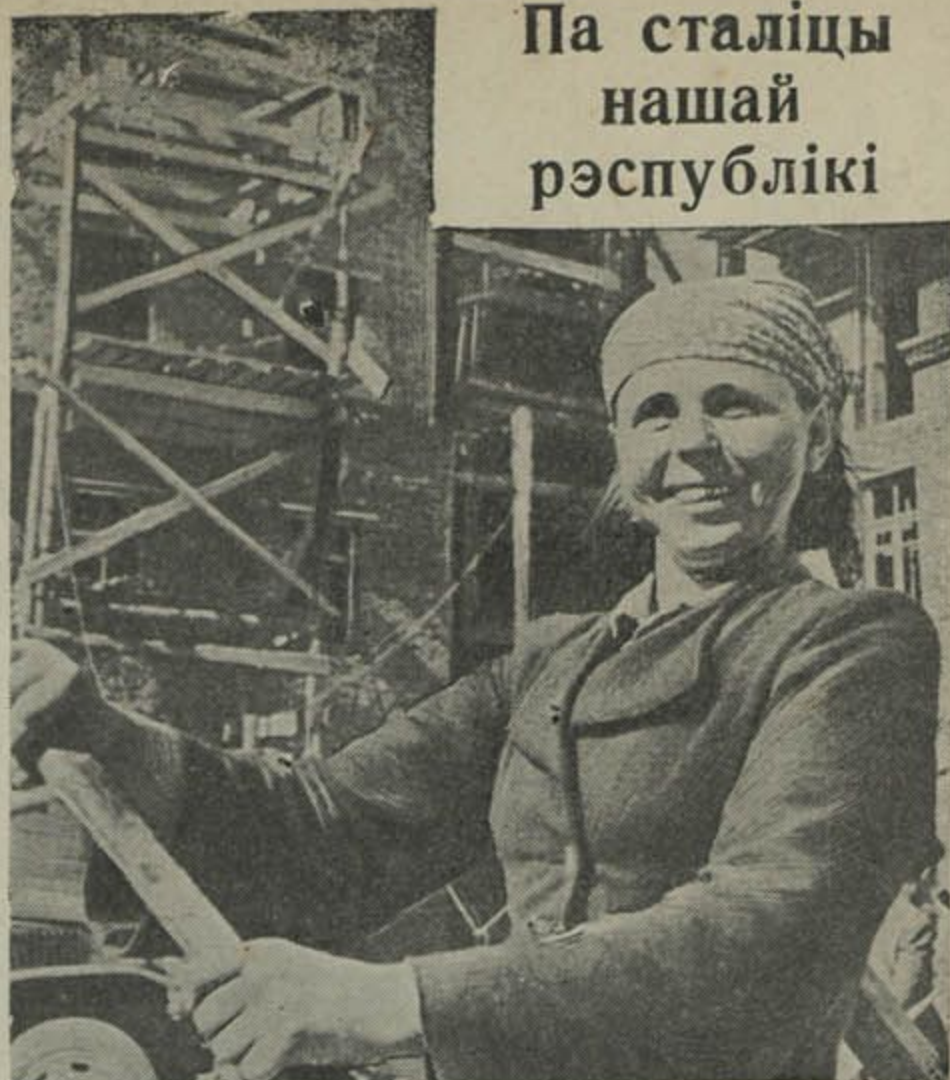
Матарыстка будаўнічага трэста № 3 Л. М. Шчэрбаціук штодня выконвае сваю норму на 170 працэнтаў.
