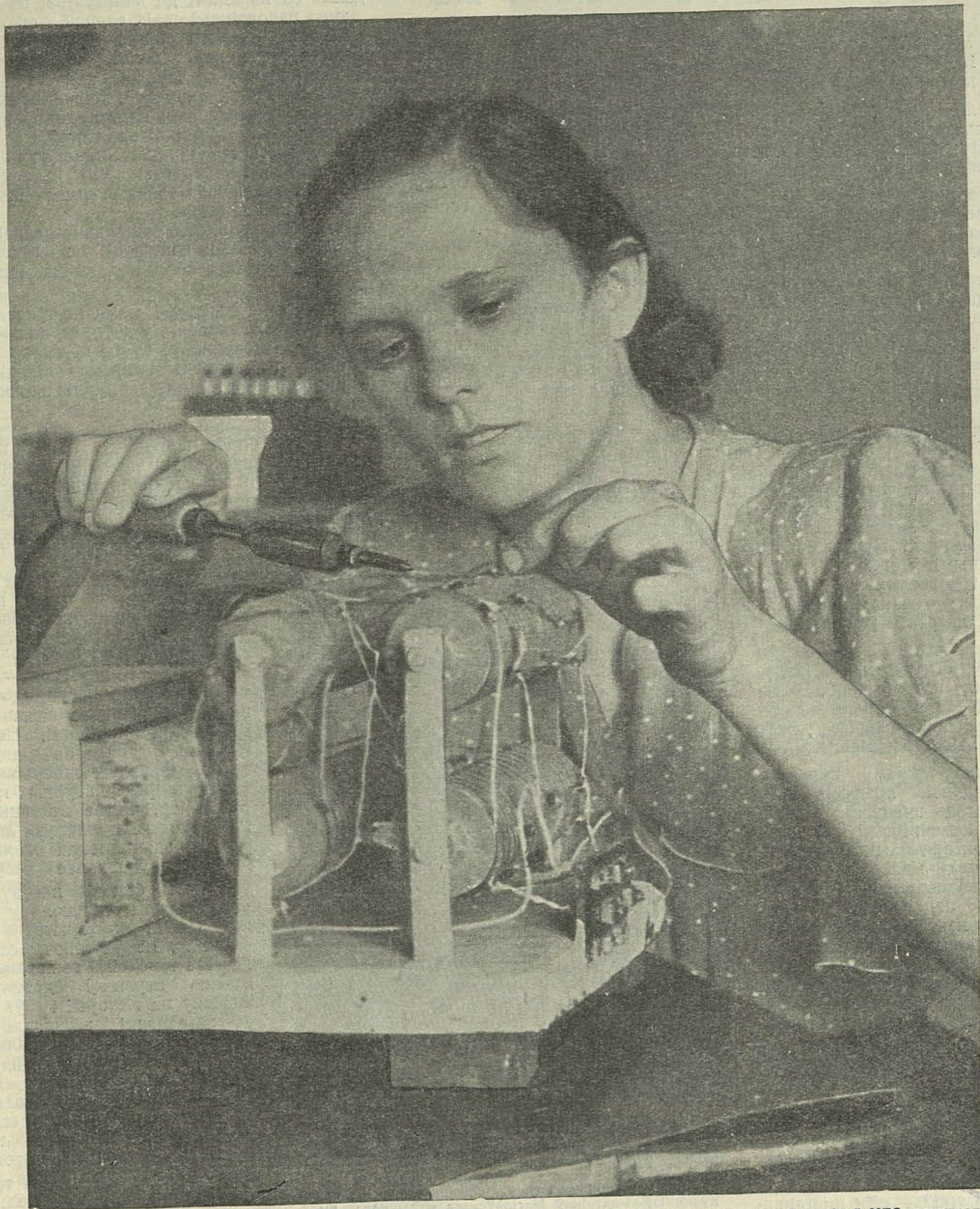
Шмат юнакоў і дзяўчат вучыцца ў Баранавіцкім тэхнічным вучылішчы № 6, якое рыхтуе радыётэхнікаў МТС, электратэхнікаў па сельскай электрыфікацыі і радыёфікацыі. На здымку: выпускніца вучылішча комсамолка Мар'я Скаўронская за ра- монтам селенавага выпраміцеля. Фото П. Нікіціна.
