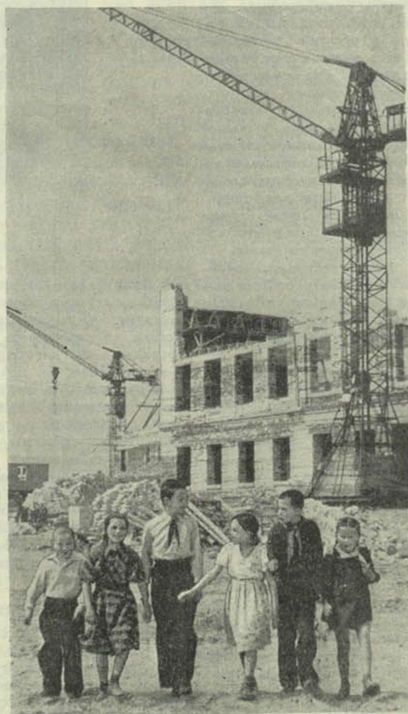
Да пачатку навучальнага года дзеці будаўнікоў атрымаюць добры падарунак — новую дзесяцігадовую школу. Дзецям не церпіцца паглядзець, як ідзе яе будаўніцтва.
