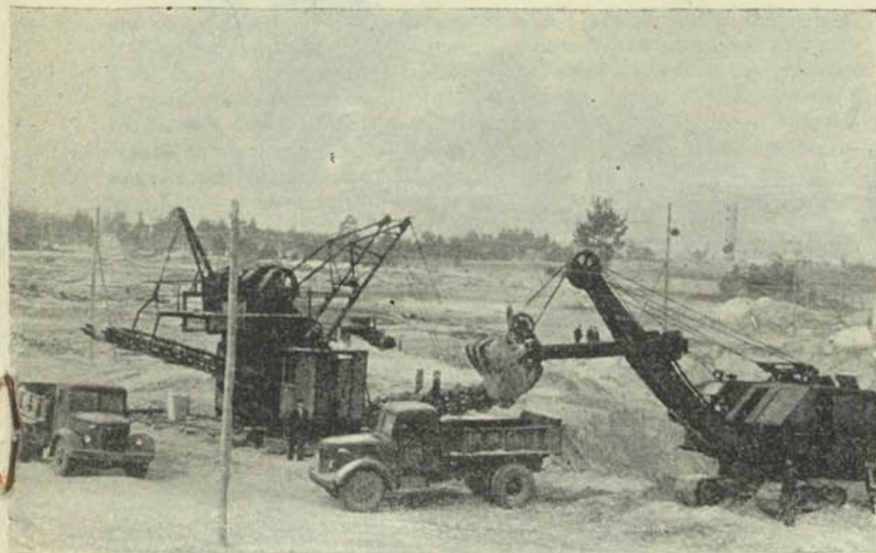
Распрацоўка катлавана пад галоўны корпус ДРЭС.
