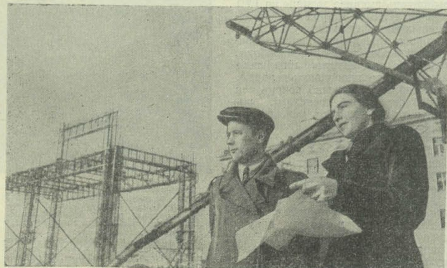
Начальнік прамучастка інжынер Уладзімір Баброў і інжынер па тэхнагляду Раіса Буракова на будаўніцтве.
