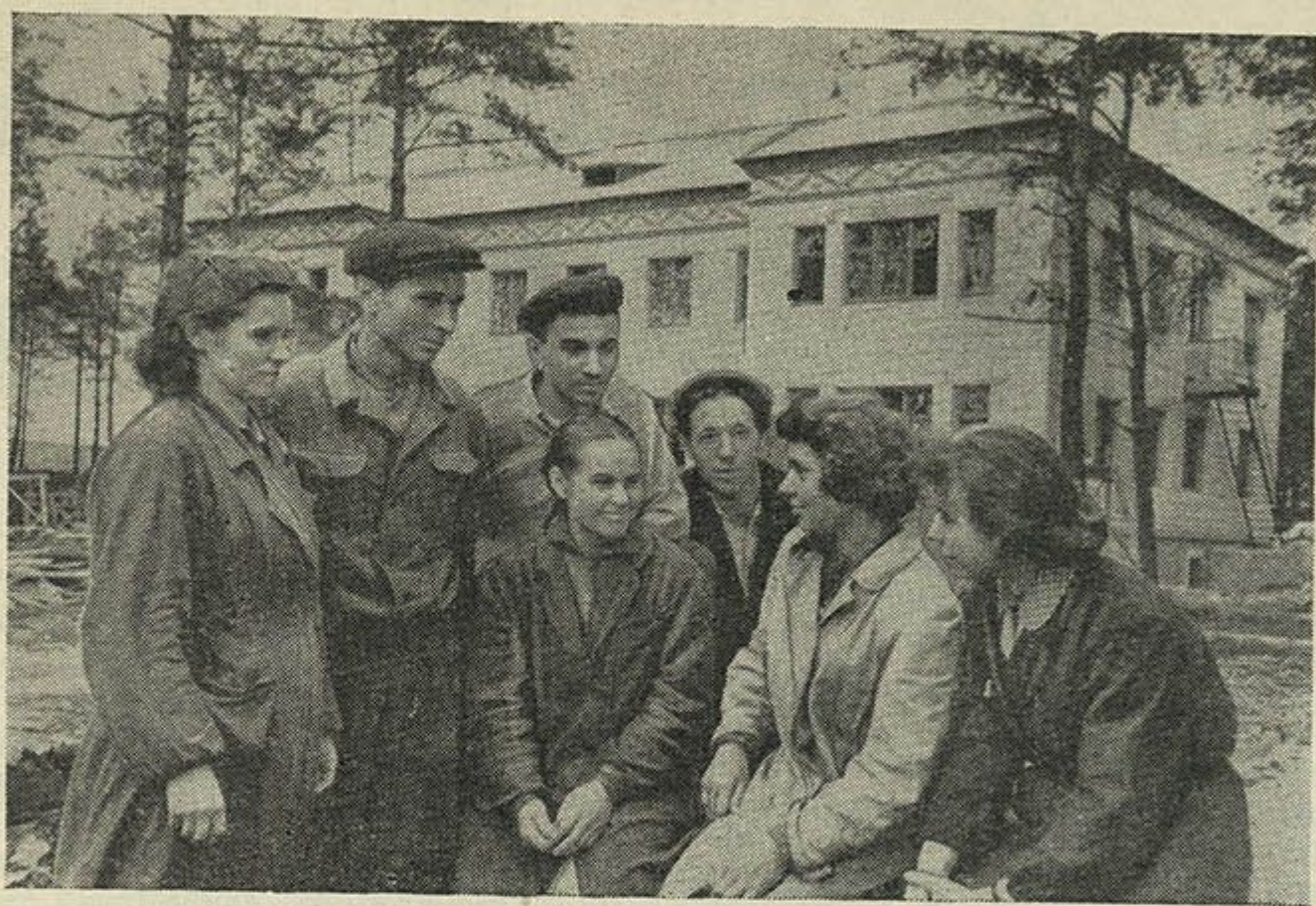
Будынак дзіцячага сада, пабудаваны рукамі аўтазаводцаў. На здымку (злева направа: кладаўшчыца эксперыментальнага цэха Любоў Абраменка, слесары рамонтна-механічнага цэха Анатоль Порах, слесар цэха шасі Георгій Лушчык, кладаўшчыца рамонтна-механічнага цэха Рэгіна Порах, слесар заводскай лабараторыі Вячаслаў Разанцаў, прараб будаўніцтва Ніна Апаровіч і інжынер аддзела галоўнага механіка Валянціна Азёрава. Фота М. Мінковіча.
