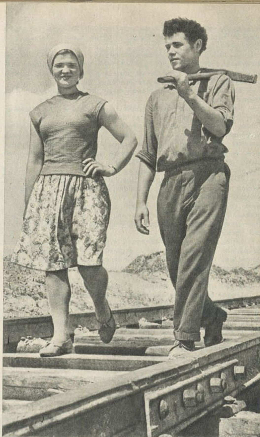
Рукі маладых узводзяць карпусы, пракладаюць цеплафікацыйныя трасы, электралініі на будаўніцтве Смалявіцкай бройлернай фабрыкі. Камсамольцы Міхаіл Казлоўскі і Галіна Свірская пракладаюць чыгуначныя пад'язныя пуці да фабрыкі.
