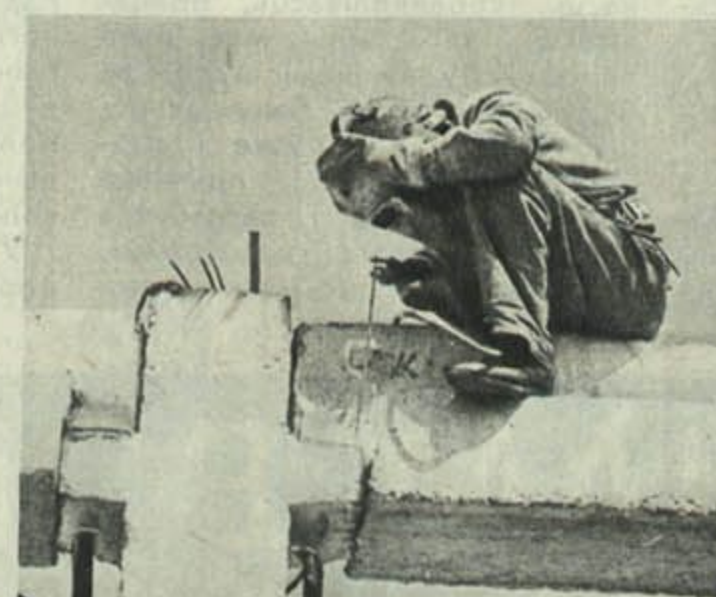
Высока над зямлёй зварвае дэталі Міхаіл Камяк.
