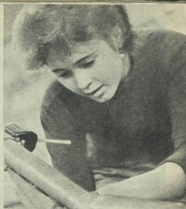
На галоўным канвееры. Аліна Восіпаўна Хрол устанаўлівае прыборны шчыток.
