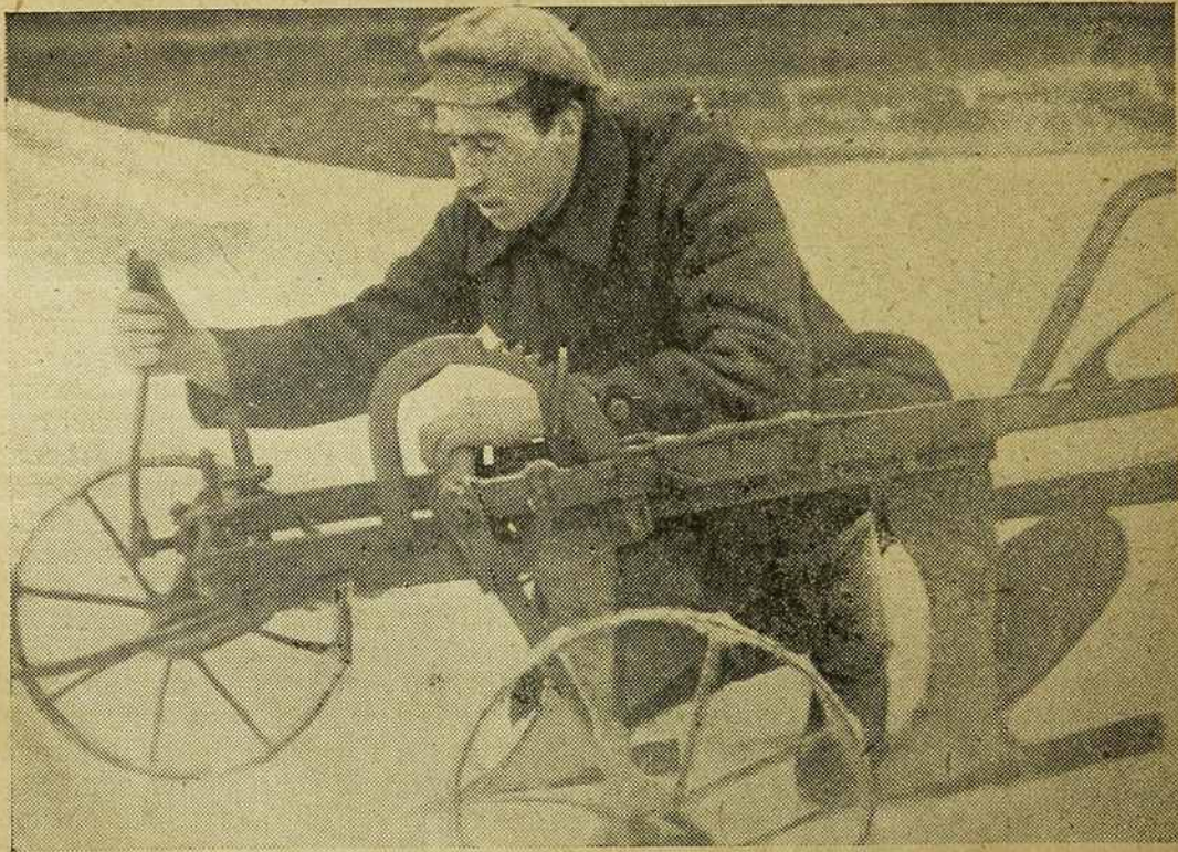
Ударнік т. Жыўтач Антос, рамантуе прычэпны трактарны плуг (камуна „Праца“, Каралінскі раён)
