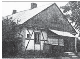
Жылы дом, пабудаваны ў тэхніцы «прускага муру», в. Заазер'е Нясвіжскага раёна (пач. XX ст.)
