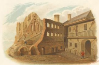
развалины старой крепости построенной в начале XVI в.
