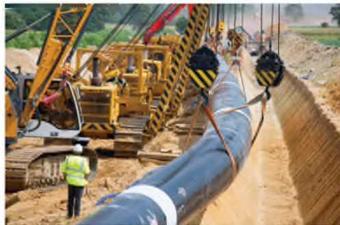
Рис. 70. Укладка газопровода
