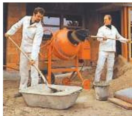
Рис. 92. Приготовление бетона — сусpenзии песка и цемента в воде
