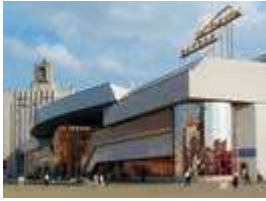
La gare ferroviaire
