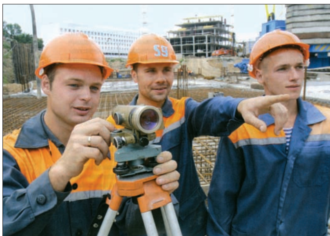
На стройке торгово-развлекательного центра в г. Витебске
