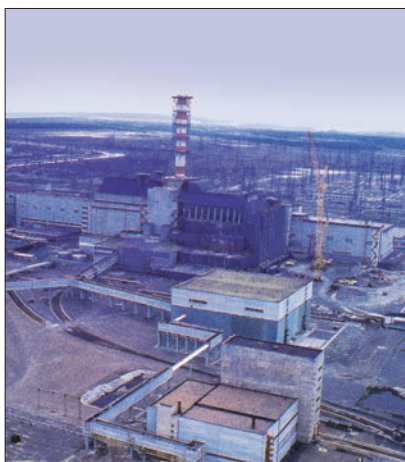
Саркофаг над разрушенным блоком Чернобыльской АЭС
