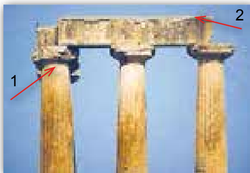
Ордар: 1 — вертыкальная апора (калона), 2 — гарызантальнае перакрыцце (бэлька)
