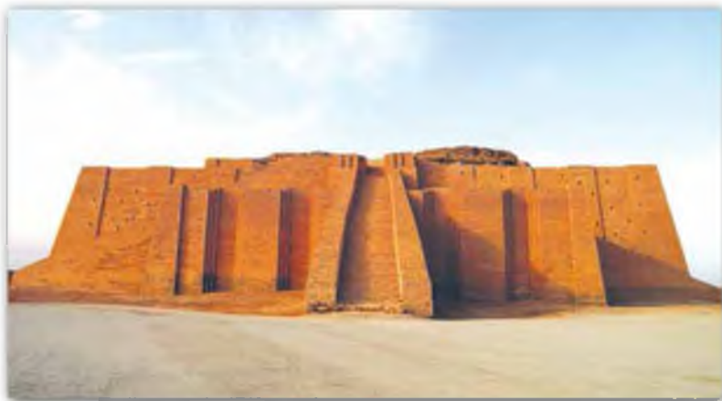
Зиккурат в Уре. Современная реконструкция
