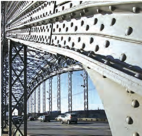
Рис. 70. Мост с соединениями конструкции на заклепках
