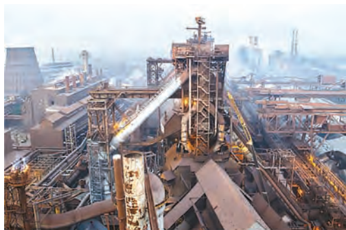
Общий вид доменной печи
