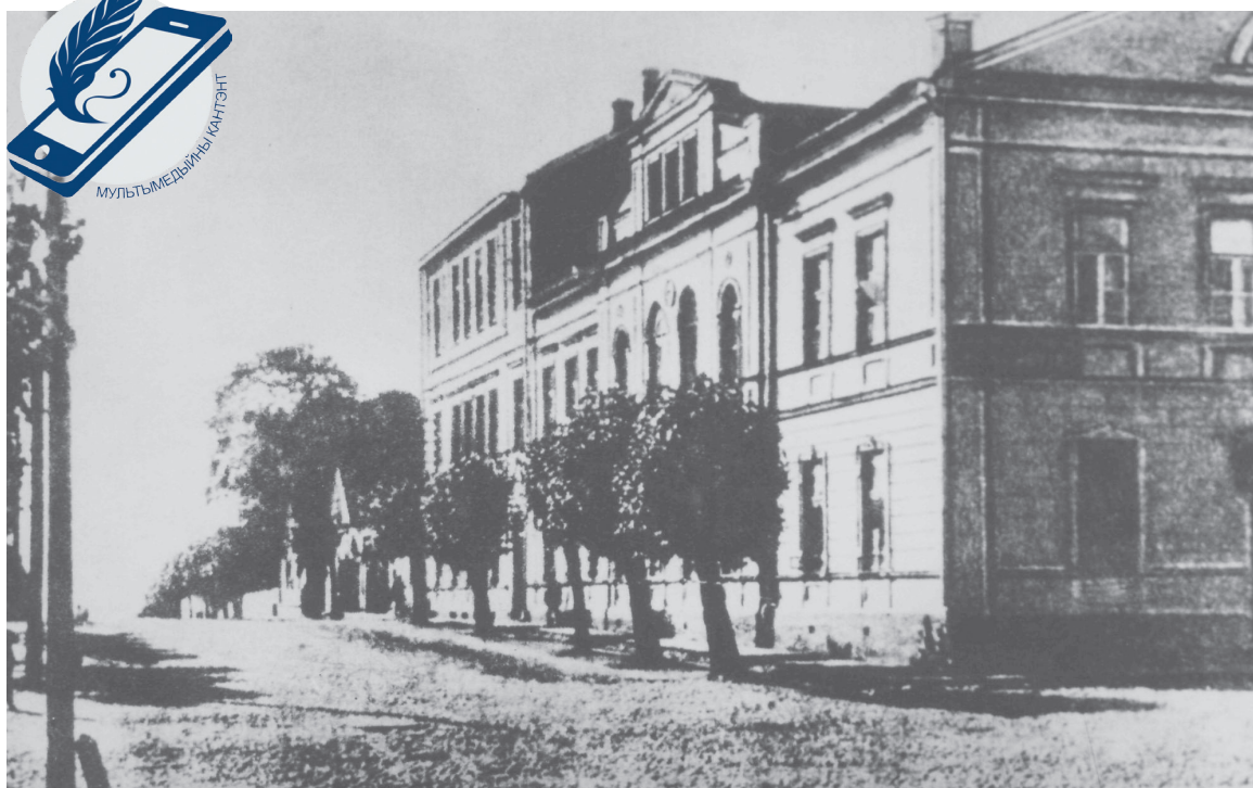
Першы будынак універсітэта на вул. Чырвонаармейскай (цяперашні гістарычны факультэт)
